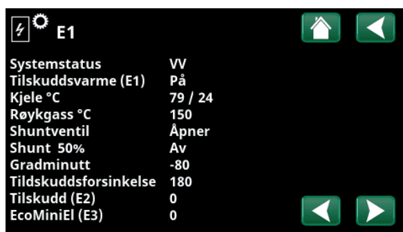
Meny «Driftsinfo E1». Klikk på pilene eller sveip i menyen for å bla mellom definerte tilskuddsvarmekilder.
