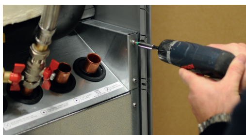
3. Poista kylmämoduulin kiinnitysruuvit.
